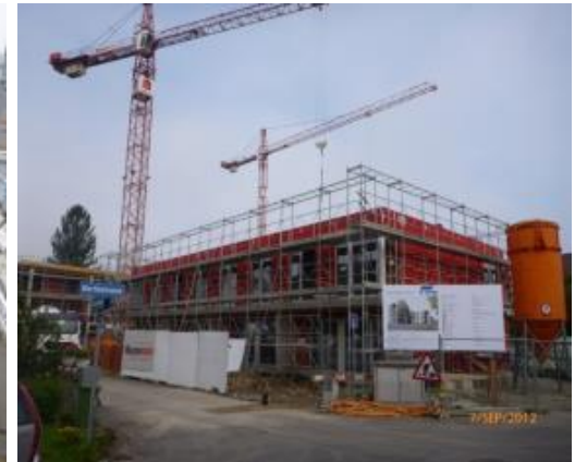
Wohnsiedlung Brüggläcker, Zürich- Schwamendingen
