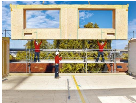
Bild 1: Vorausseilendes Fassadengerüst
