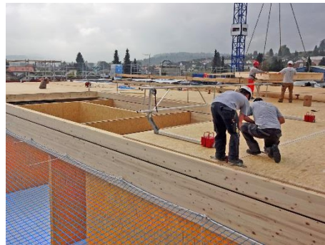
Bild 5: Absturzsicherung durch Auffangnetz und Seitenschutz
