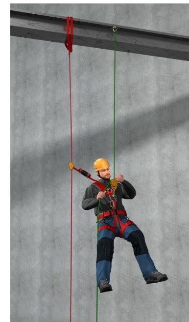
Bild 2: Systemredundanz durch unabhängig fixiertes Arbeits- und Sicherungsseil (Bild m. Gen. DGUV)
