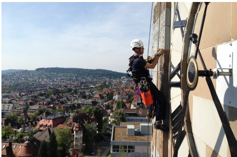
Bild 1: SZP erfolgt immer mit redundanten Systemen (Bild z. V.)
