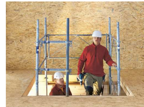
Img 6: Scala a torre come protezione anticaduta
