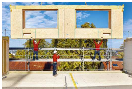
Img 1: ponteggio di facciata montato prima
