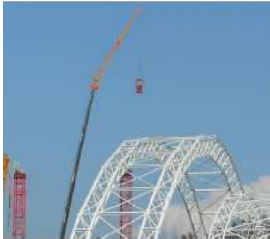
1 Un'alternativa sicura per non doversi arrampicare per 85m fino al nodo superiore della struttura a ponte, è il cestello da lavoro dal quale si può uscire e risalire (ottemperare a quanto previsto nelle normative nazionali!)
