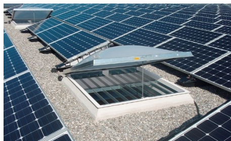
Sono necessarie misure contro lo sfondamento anche quando si lavora con i DPI
