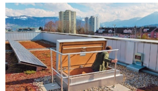
Scala interna con parapetto laterale (Immagine: Suva)
