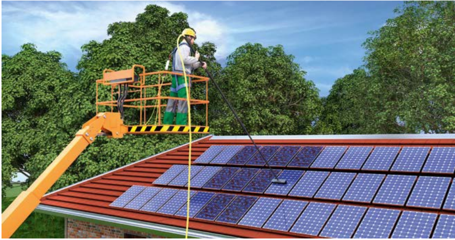
Pulizia dell'impianto FV dalla PLE senza calpestare il tetto; Figura: BG BAU
