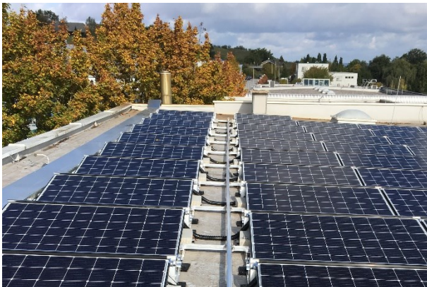
Dispositivo di arresto lineare portante per DPI (sistema a binario), certificato in combinazione con la sottostruttura dell'impianto solare. Immagine: a.d.
