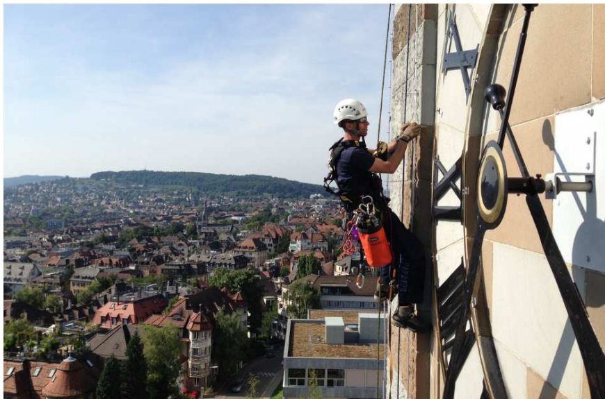
Figura 1: SAP sempre con sistemi ridondanti (Figura z. V.)
