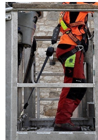
Img 2: Mezzi di collegamento durante il lavoro più corti possibili
