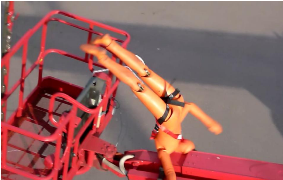
Bild 2: Sturzsequenz aus Teleskoparbeitsbühne durch Katapulteffekt (Peitscheneffekt) und Einsatz eines zu langen Verbindungsmittels. → Videos auf www.bauforumplus.eu/absturz
