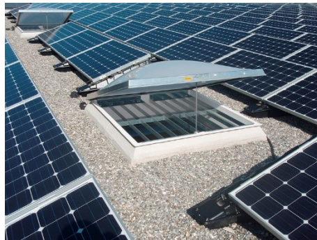
Auch beim Arbeiten mit PSAgA sind Massnahmen gegen Durchbruch erforderlich
