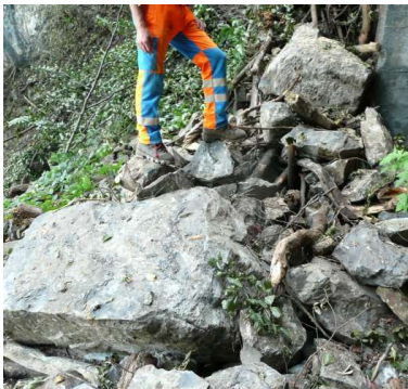
2 I rischi connessi al lavoro nel settore dei pericoli naturali devono essere costantemente rivalutati.
