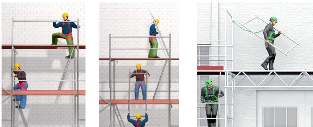
Img 5-7: Procedura di montaggio con parapetto provvisorio e DPI anticaduta per ponteggiatori
