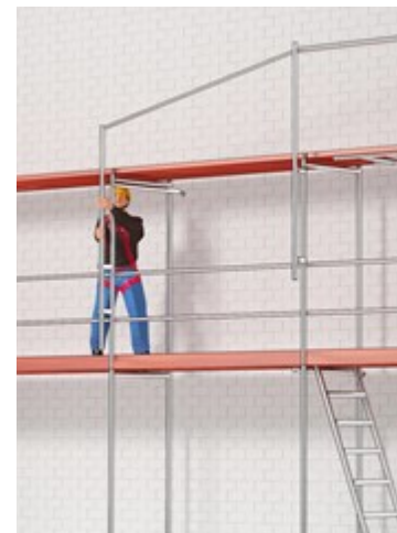
Img 3 Montaggio con parapetto provvisorio
