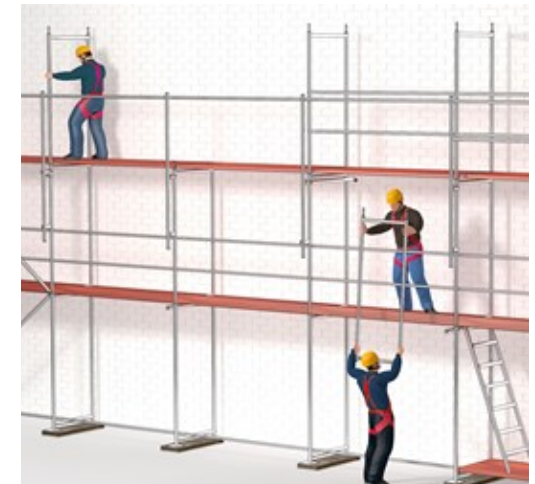
Img 4 Montaggio protetti dal parapetto provvisorio
