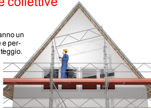
Img 1 Montaggio: sistema a parapetto montato dal piano inferiore
