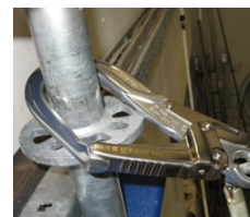
Img 9: Metodo d'attacco solo per ganci in acciaio ammessi per questo
