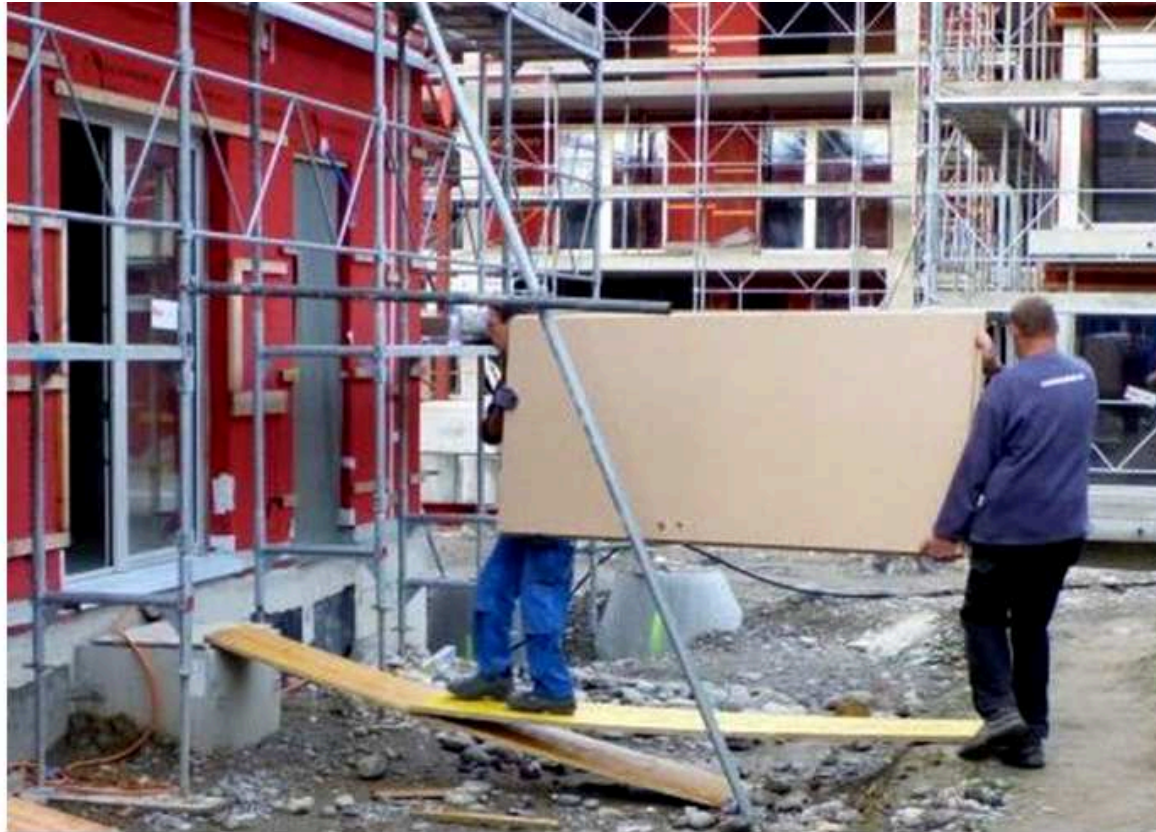
Baustelle Brüggläcker – Zürich: Bauetappe I – ohne OptiBau
